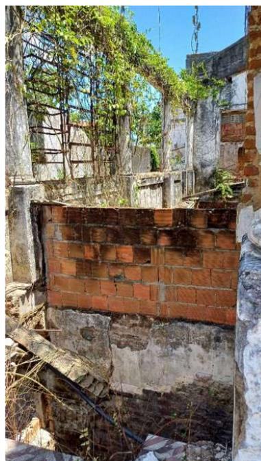
Fig. 05 e 06 Vista de acesso aos alpendres laterais: ferragens expostas e corroídas, laje de piso destruída, estrutura de cobertura inexistente, invasão de vegetação na estrutura, alvenarias de vedação comprometidas.
