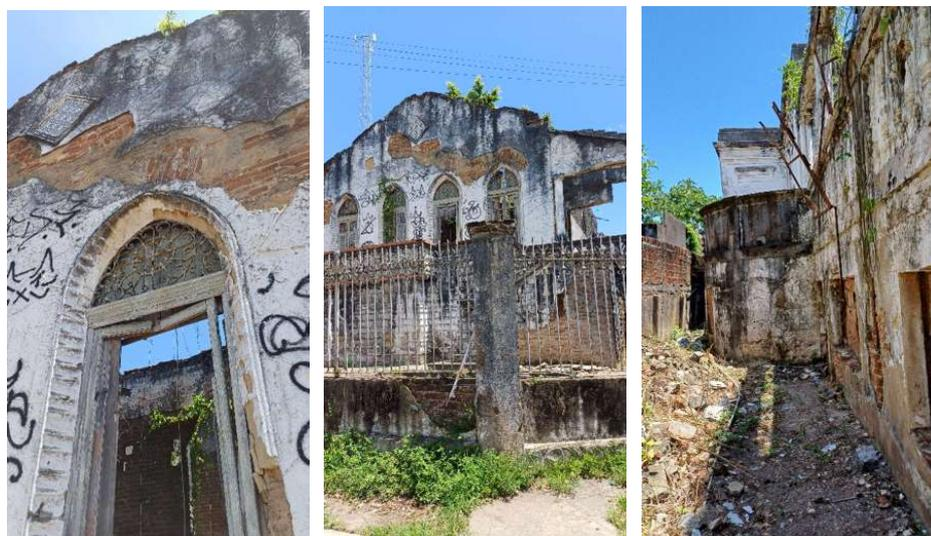
Fig. 10, 11 e 12 Reboco original da fachada descolado, moldura da abertura danificada, esquadrias quebradas ou inexistentes, fachada lateral deteriorada, presença de bastante entulho no terreno.
