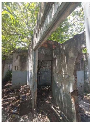
Fig. 13 e 14 Deterioração da alvenaria e cobertura não existente.
