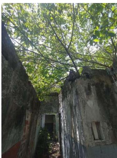
Fig. 15 e 16 Ambiente sem proteção de cobertura e vegetação infiltrada na alvenaria
