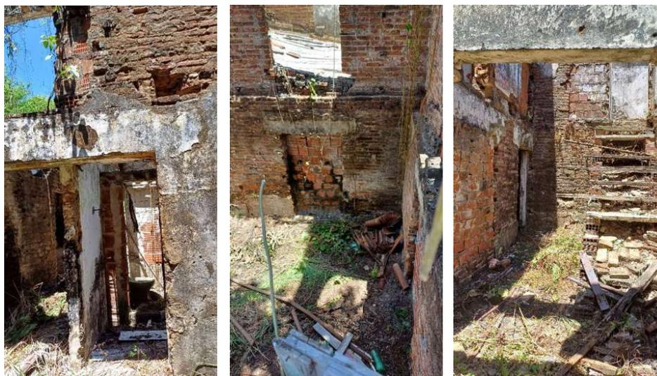
Fig. 07, 08 e 09 Lajes de piso inexistentes, alvenaria original deteriorada, emparedamento de aberturas, cobertura metálica improvisada, escada de acesso do porão para o piso superior.
