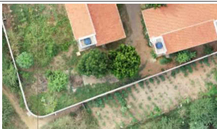
Figura 04 – Novo local de instalação do Sistema de tratamento
