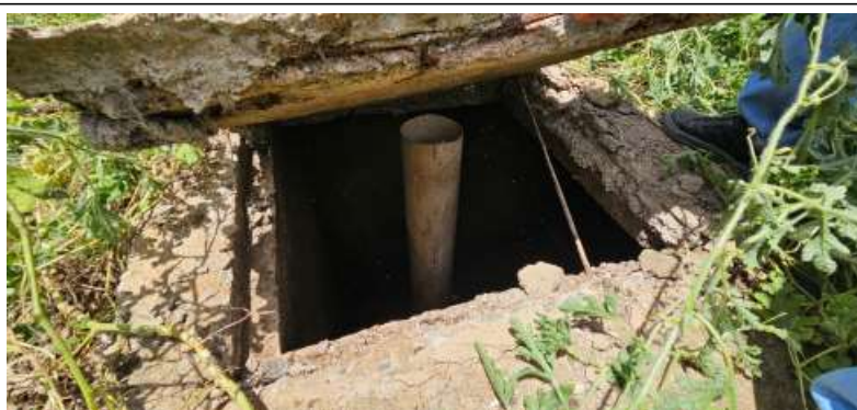
Figura 12 – Filtro Biológico praticamente seco
