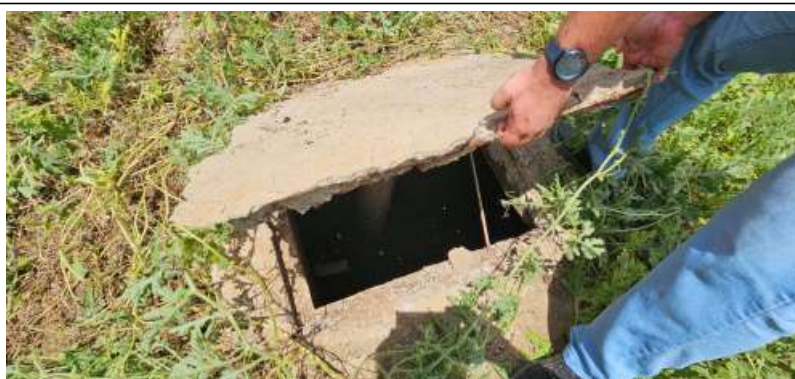
Figura 13 – Filtro Biológico praticamente seco
