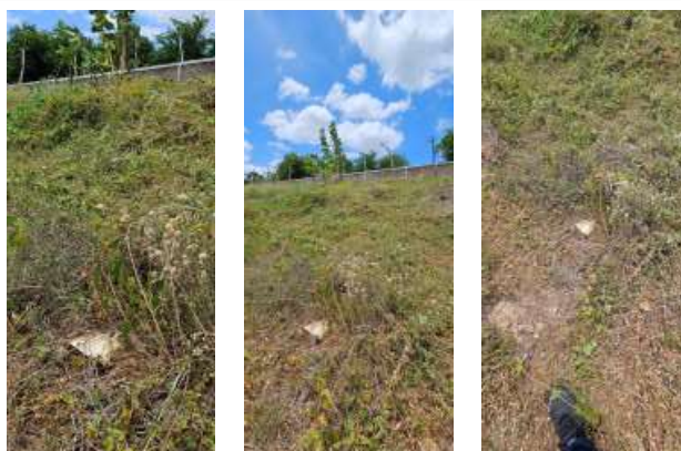
Figura 14 – Tubulação de Saída do Efluente tratado completamente achatada
