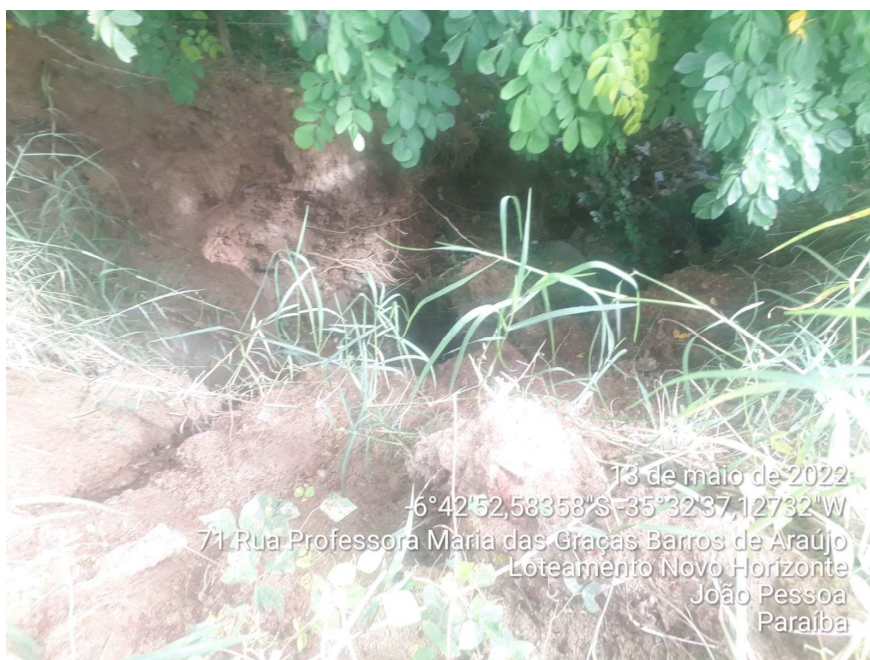
Figura 01 – Deslizamento do trecho com a tubulação de drenagem
