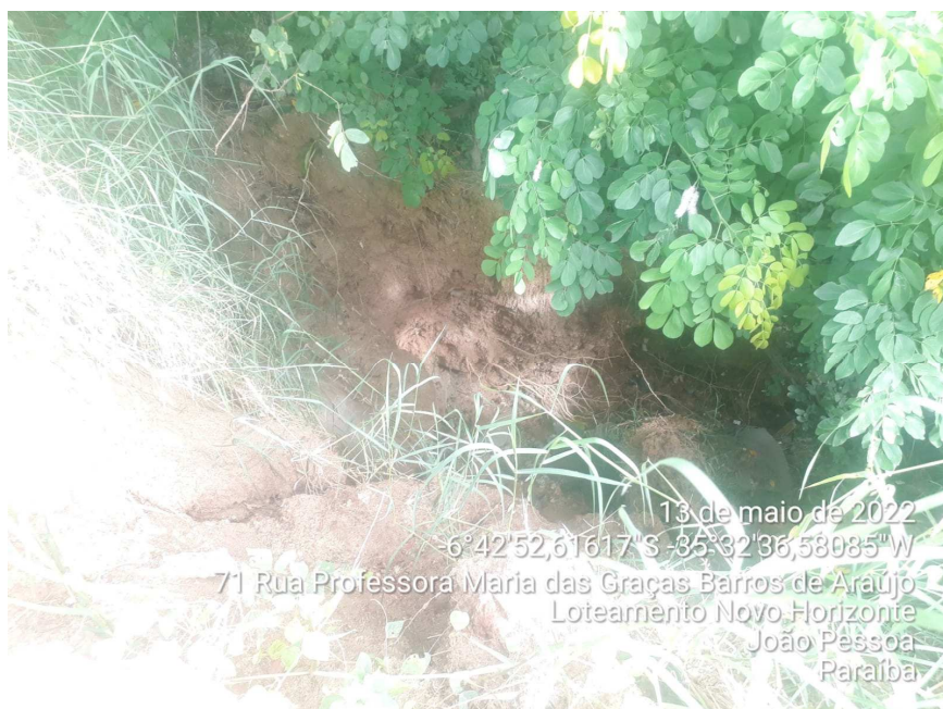
Figura 03 – Área do deslizamento do trecho da rede de drenagem
