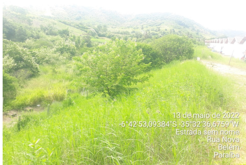
Figura 04 - Talude e diferença de nível no local
